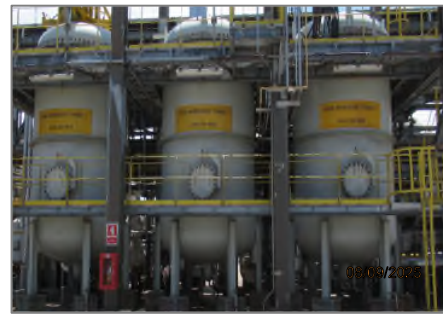
ภาพถ่ายที่ 2.2.1-7 หอเหล็กไฮดรอกไซด์ สำหรับกำจัดซัลเฟอร์
