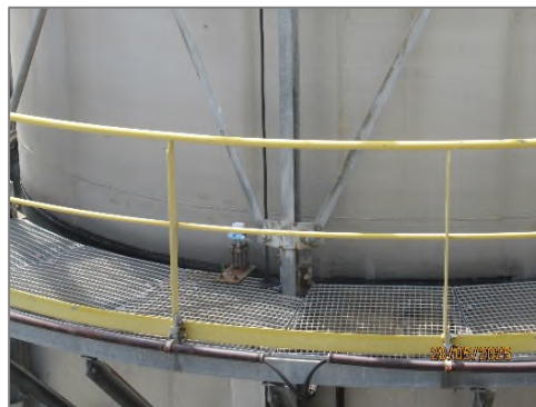
ภาพถ่ายที่ 2.2.1-42 อุปกรณ์วัดระดับแบบวัดเฉพาะ จุดแบบ Local Scale
