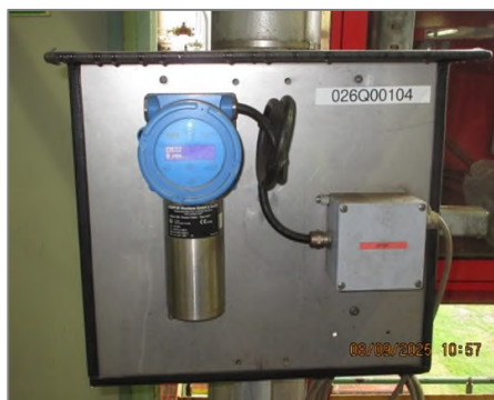
ภาพถ่ายที่ 2.2.1-55 เครื่องตรวจวัดฟอสจีน (Phosgene Detector)
