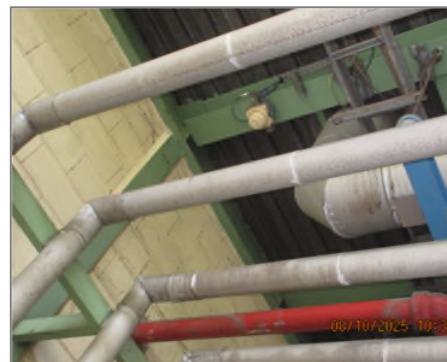
ภาพถ่ายที่ 2.2.1-60 เครื่องตรวจจับก๊าซไวไฟ (Flammable Gas Detector)
