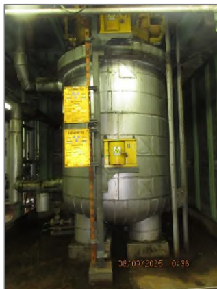
ภาพถ่ายที่ 2.2.1-54 ถังพัก (Buffer Vessel)
