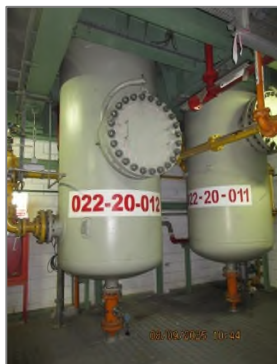
ภาพถ่ายที่ 2.2.1-1 ระบบกำจัดก๊าซฟอสจีน (Phosgene Decomposition System)
