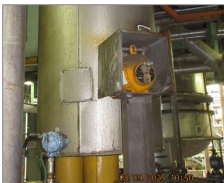
ภาพถ่ายที่ 2.2.1-43 อุปกรณ์วัดระดับแบบวัดค่าต่อเนื่อง
