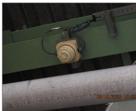
ภาพถ่ายที่ 2.2.1-60 เครื่องตรวจจับก๊าซไวไฟ (Flammable Gas Detector)
