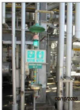
ภาพถ่ายที่ 2.2.1-38 ฝักบัวฉุกเฉินและอ่างล้างตาฉุกเฉิน ส่วนผลิต CO
