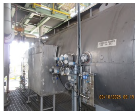
ภาพถ่ายที่ 2.2.1-4 ระบบ Thermal Oxidizer (TO)
