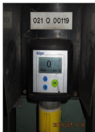
ภาพถ่ายที่ 2.2.1-55 เครื่องตรวจวัดฟอสจีน (Phosgene Detector)
