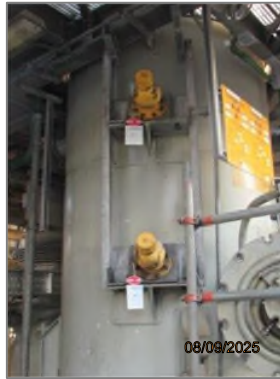
ภาพถ่ายที่ 2.2.1-6 ระบบ Interlock สำหรับหยุดการป้อนโค้ก
