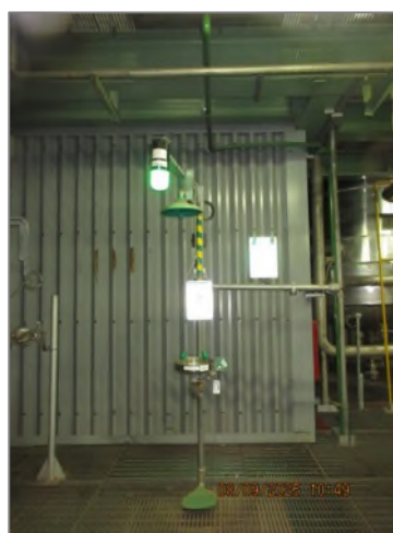
ภาพถ่ายที่ 2.2.1-34 อุปกรณ์คุ้มครองความปลอดภัยส่วนบุคคลสำหรับพนักงานที่ต้องเข้าไปปฏิบัติงานในหน่วยผลิตฟอสจีน
