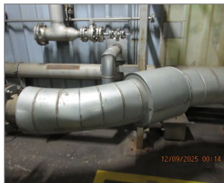
ภาพถ่ายที่ 2.2.1-28 อุปกรณ์ครอบเครื่องจักรที่มีเสียงดัง
