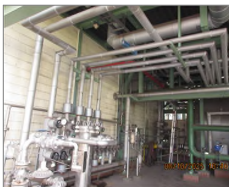
ภาพถ่ายที่ 2.2.1-4 ระบบ Thermal Oxidizer (TO)
