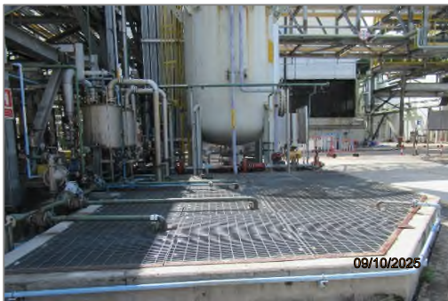
ภาพถ่ายที่ 2.2.1-16 บ่อรวบรวมน้ำเสีย (Wastewater Sump) ของส่วนผลิต CO
