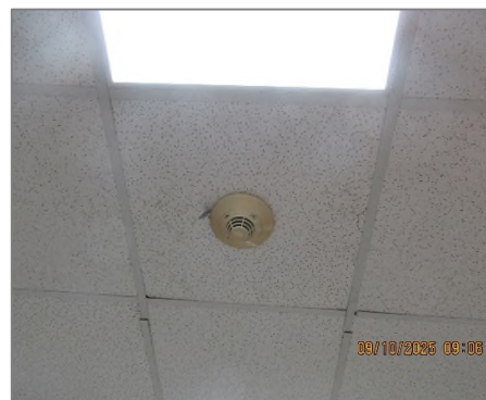
ภาพถ่ายที่ 2.2.1-59 Smoke Detector และ Smoke Detector บริเวณส่วนผลิต PC
